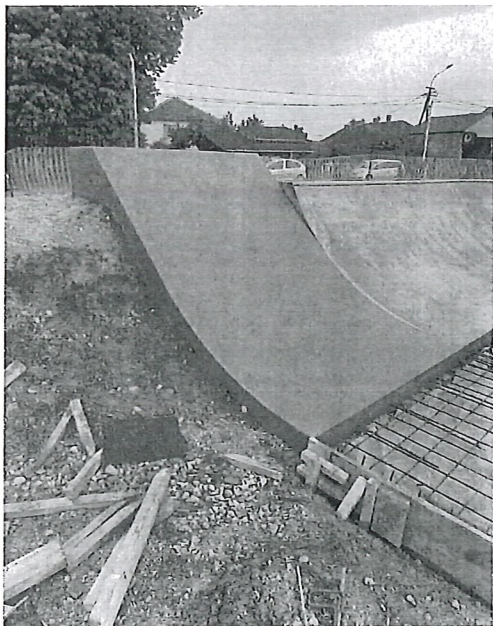
Kép 6: Frissen simított elem
